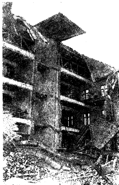
Obr. 4. Průčelní zeď vypadla účinkem horizontálního pohybu půdy kolmého na její směr. (Archiv Stát. ústavu geofysikálního.)
